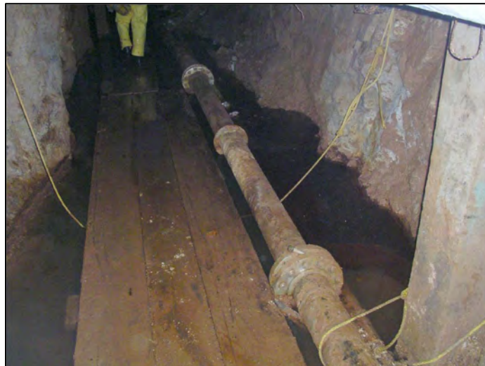
STAINLESS STEEL PIPE STA 6+39 TO STA 6+50 (2001)
